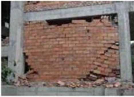
آسیب ناشی از فشار و برش در میانقاب
