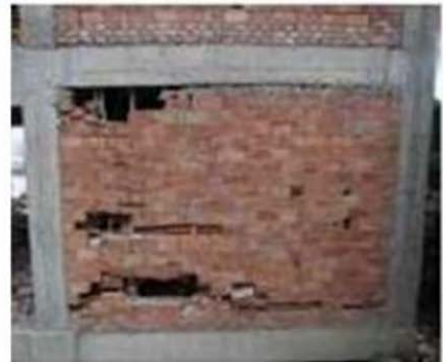
آسیب ناشی از فشار در میانقاب
