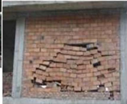
آسیب ناشی از برش در میانقاب
