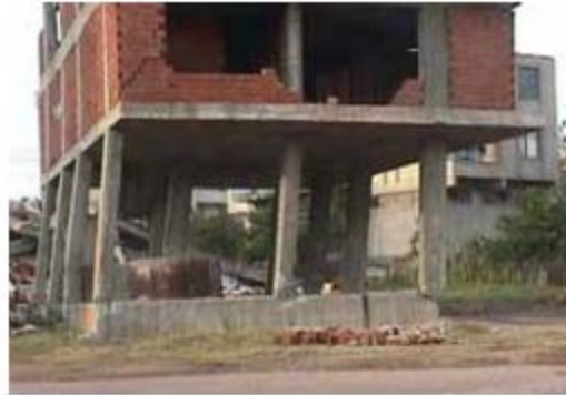
تغییر شکل ناشی از طبقه نرم
